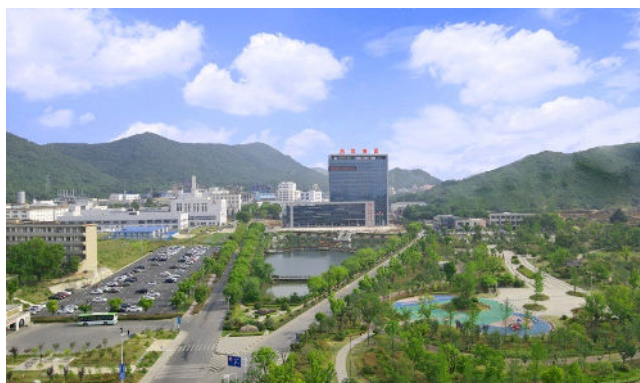
皖维集团安徽总部（石油乙烯法，在建）
