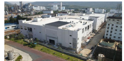
新建偏光片厂房 POLARIZER PLANT
